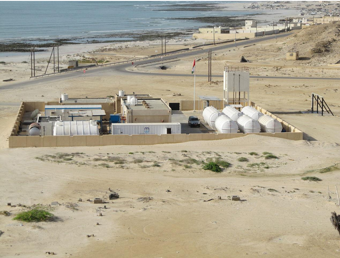
Опреснительная установка, Оман
